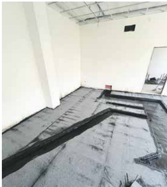
I. etapa modernizace učeben – ZŠ Neštětická, podlahy
