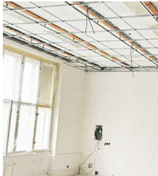
I. etapa modernizace učeben – ZŠ Palachova, omítky
