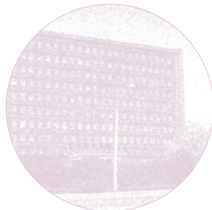
22. Správní budova Spolchemie
