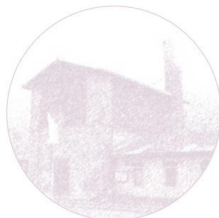
18. Parní vodárna Střekov
